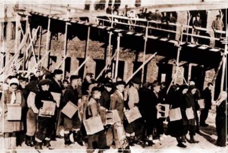
Jesień, 1954 roku. Uczniowie pomagający przy budowie szkoły
