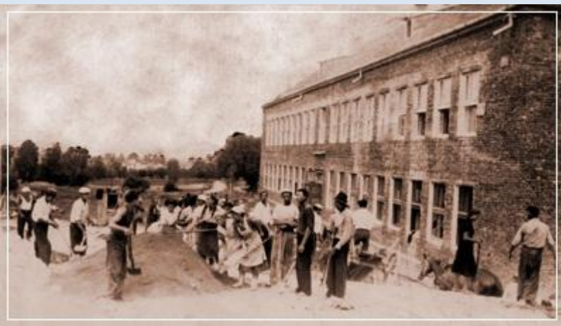
Budowa nowej szkoły (lata 50-te)
